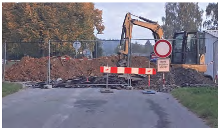
Výstavba kanalizace pro Svazkovou školu pod Skalkou
