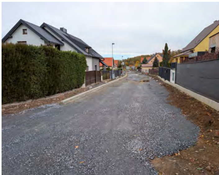
Rymaňská ulice – stav prací na konci října
