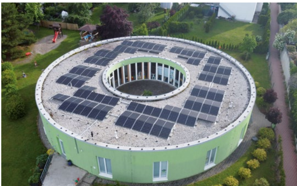
Fotovoltaické panely na střeše MŠ Nová – detašované pracoviště v Edenu
