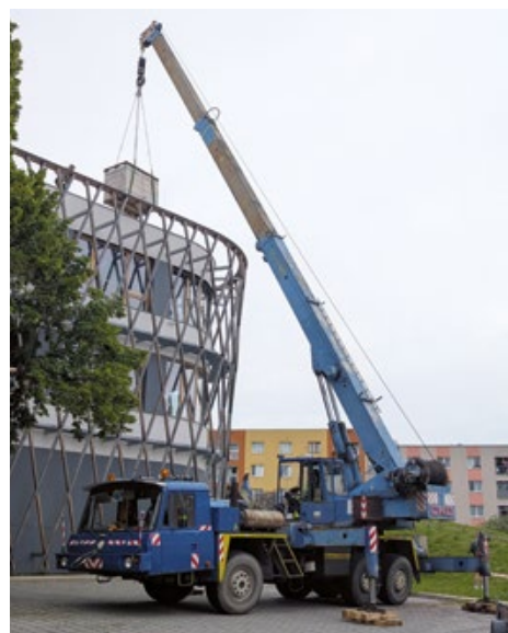
Na střechu Pavilonu dopravil fotovoltaiku autojeřáb
