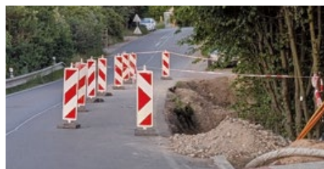
V úseku propustku je od konce května částečná uzavírka
