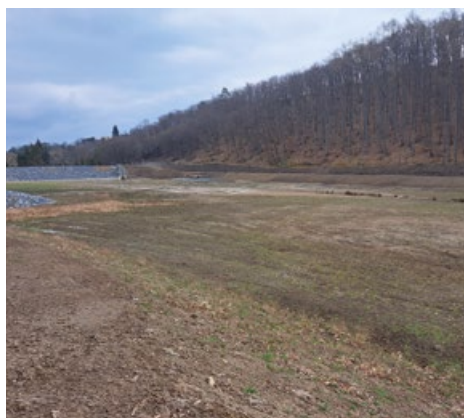
Rybník v průběhu stavby
