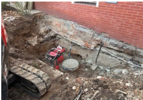
Umísťování nového lapolu za budovou kuchyně Domova pro seniory Pod Skalkou
