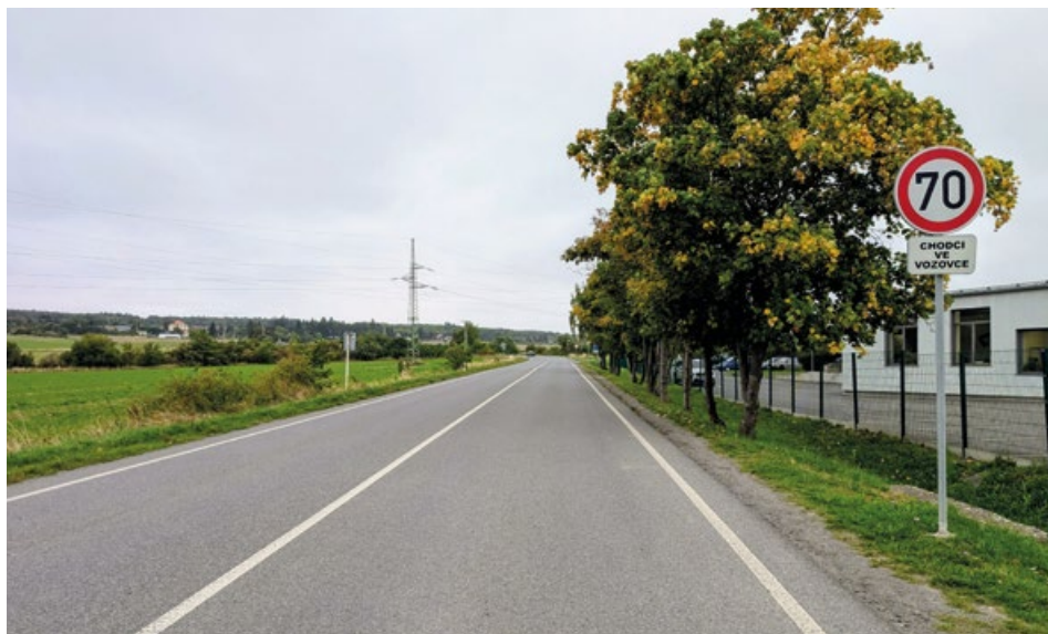
Nový chodník povede podél pravé strany silnice až k železničnímu přejezdu
