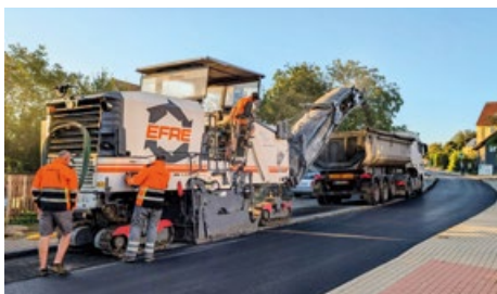
Frézování Dobříšské silnice
