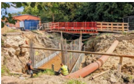
Stavba nového mostu v Řevnické ulici
