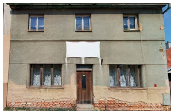
Dům ještě projde kompletní rekonstrukcí
