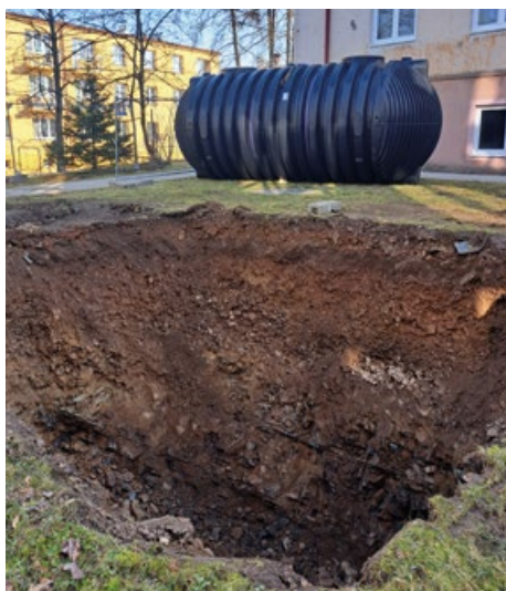
Jedna z retenčních nádrží čeká na umístění do vyhloubené jámy
