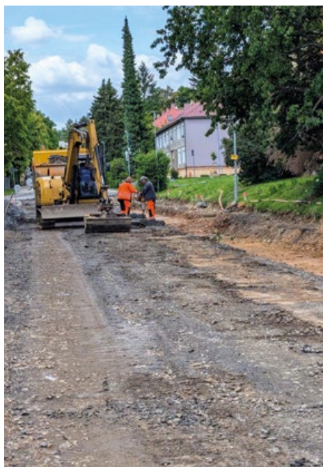
Stavební práce ve Lhotecké ulici
