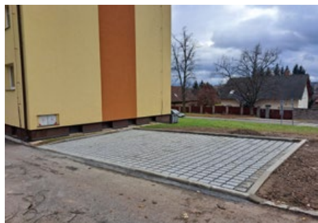
Tři parkovací stání vedle bytového domu č. p. 514
