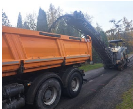
Fréza při práci v Kamenném
