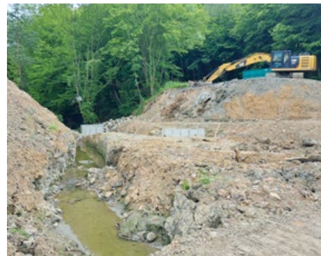
Část hráze po demolici
