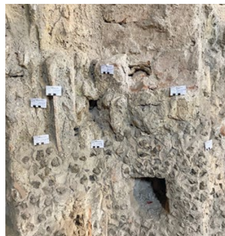
Sondy provedené ve štukové výzdobě
