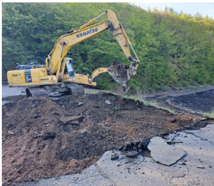
Zahájení demolice hráze rybníka
