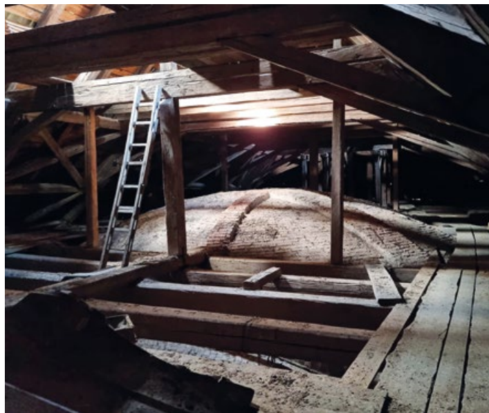
Krov s kostelní klenbou
