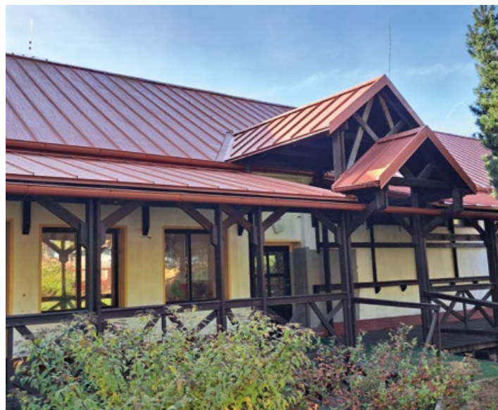
Část nové střechy mníšeckého domova pro seniory
