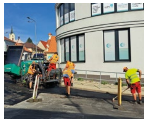
Asfaltování zatáčky u Pasáže Pražská
