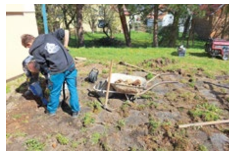
Práce na novém chodníku
