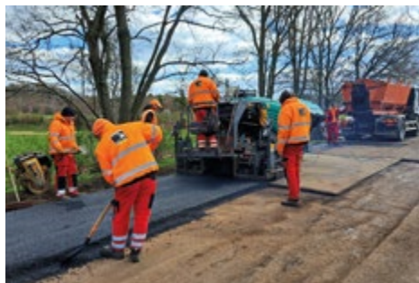
Oprava Nádražní ulice u hřbitova
