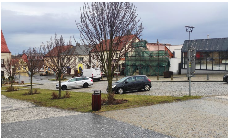
Stavba by na pět měsíců zablokovala dolní část náměstí
