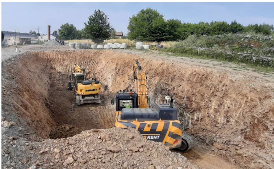
Fotografie pochází z výkopu o něco menší nádrže na dešťové vody při stavbě obchvatu města Jílové u Prahy v roce 2022. Podobný výkop by byl proveden i u nás. Byl by ale ještě větší, než vidíte na obrázku.
