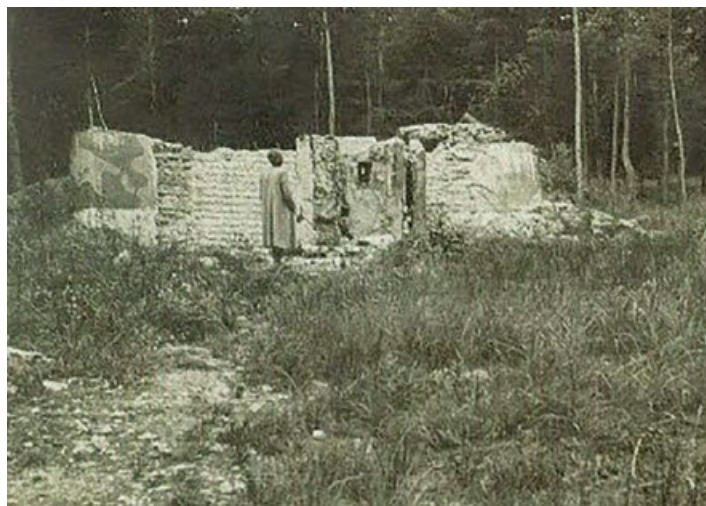
Zničený bunker v lese nad Mníškem
