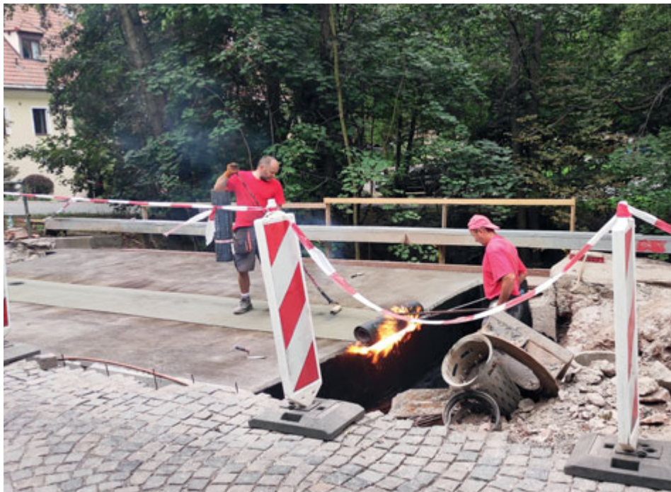
Stavební práce běží na mostku přes Bojovský potok od začátku srpna
