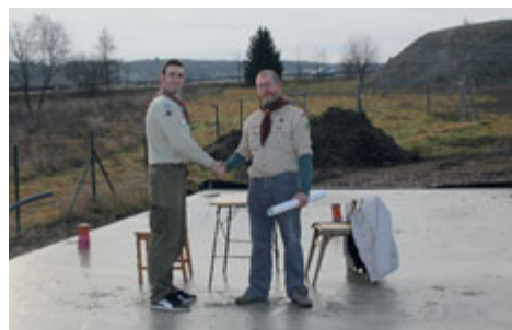
Roman Freisleben a David Bílek pózují na dokončené základové desce (listopad 2019)
