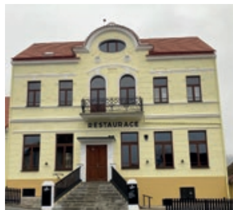
Sokolovna po rekonstrukci prokoukla (podzim 2021)
