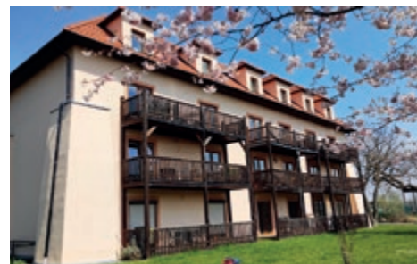
Současný stav objektu (2021). Foto: autor
