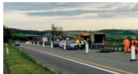
Stavební práce na dálnici započaly 17. května. Foto: autor
