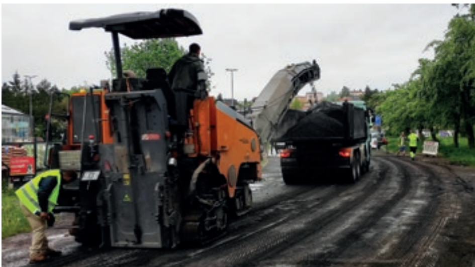
Po vyfrézování povrchu (na fotce) nastoupil práci asfaltovací stroj
