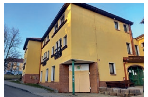
Školková třída vznikne v přízemí budovy mníšeckého Domečku. Foto: archiv
