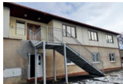
Testování bude probíhat v přízemí kulturního střediska. Foto: autor
