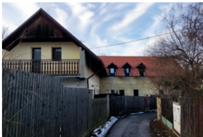
Budova bývalé zámecké kovárny (současný stav)
