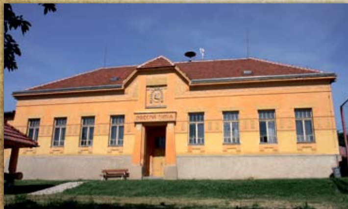
Současná školka po rekonstrukci
