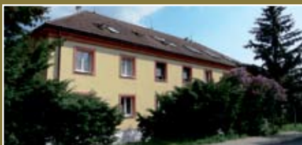
Byt 1+1, 33 m² , po pečlivé rekonstrukci, Staré sídliště, Mníšek. Cena: 1 330 000 Kč.
