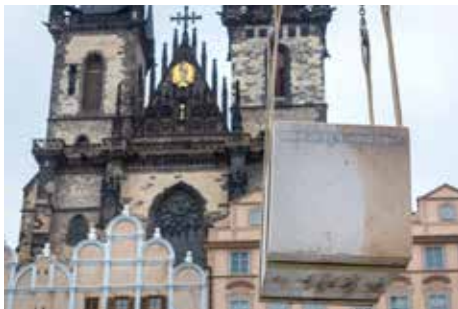
Tunový kámen do základů přenáší jeřáb. Foto Martin Frouz
