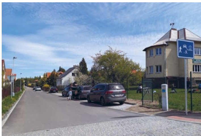
Švermova ulice po rekonstrukci
